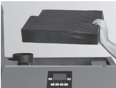
Fig. 45 Rimuovere l'isolamento
