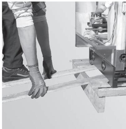
Fig. 10 Collocare le assi della gabbia a mo' di rampa
