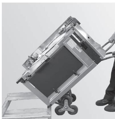
Fig. 14 Sollevare la caldaia dal pallet con la slitta
