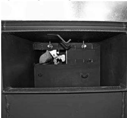
Fig. 118 Pulizia del sensore thermocontrol BioWIN XL 350, 450
