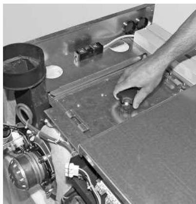
Fig. 27 Rimuovere il collegamento a vite
