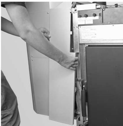
Fig. 57 Infilare il rivestimento anteriore
