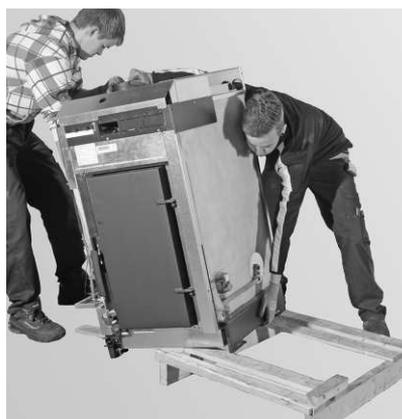
Fig. 12 Rimuovere la caldaia dal pallet
