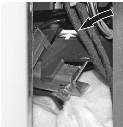
Fig. 38 Avvitare saldamente le viti di fissaggio in alto fino alla battuta (marcatura)
