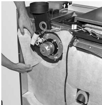
Fig. 30 Rimuovere l'isolamento sul ventilatore gas combusti
