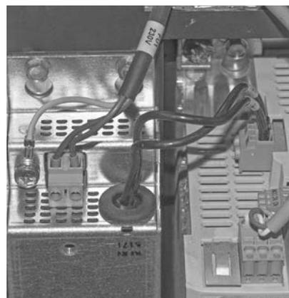
Fig. 97 Collegare cavo e messa a terra, inserire la spina
