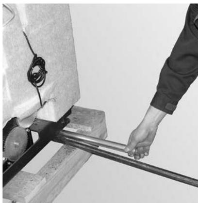
Fig. 9 Collocare la barra di ferro sotto la caldaia
