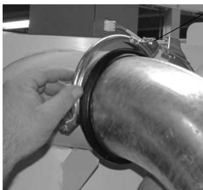
Fig. 164 Fissare le curve con guarnizione e anello di serraggio
