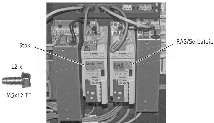
Fig. 96 Montare e inserire i convertitori di frequenza
