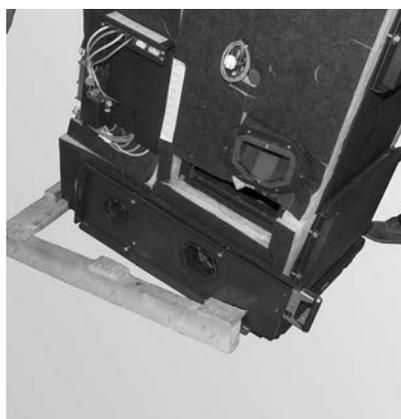
Fig. 13 Inclinare la caldaia in avanti e rimuovere il pallet di base
