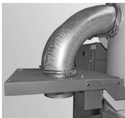
Fig. 167 Agganciare l'elemento di chiusura, montare le curve sull'elemento di chiusura
