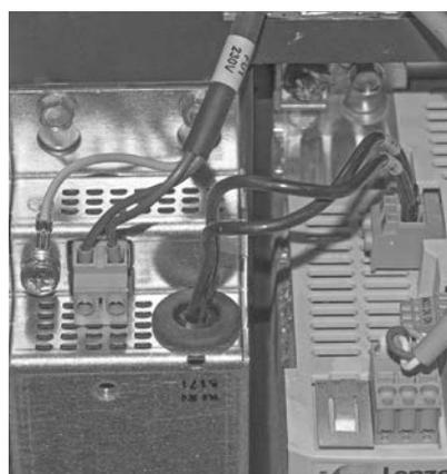
Fig. 191 Collegare filtro di rete e FU, cavo e messa a terra, inserire le spine
