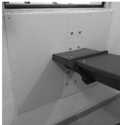
Fig. 142 Montare le lamiere di copertura all'esterno
