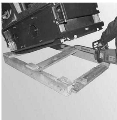
Fig. 12 Inclinare la caldaia all'indietro, segare le assi orizzontali anteriori e rimuoverle
