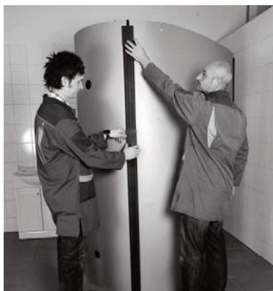
Abb. 32 Collegare due pezzi di isolante
