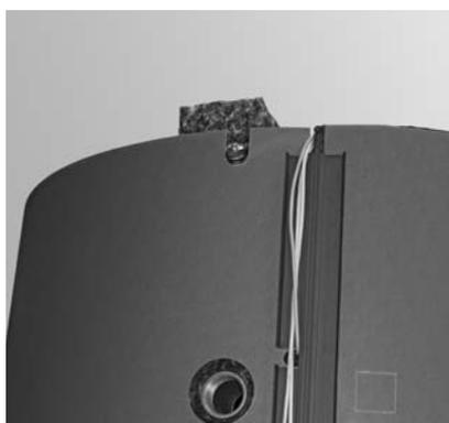
Fig. 45 Cavi del sensore all'esterno del puffer.
