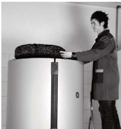
Fig. 35 Inserire la parte di isolamento superiore
