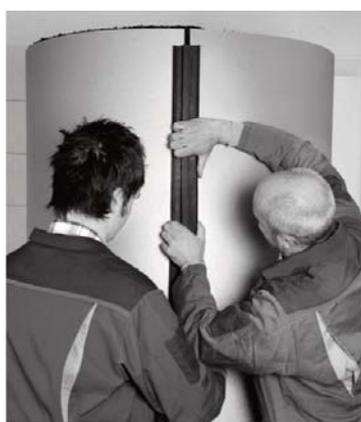
Fig. 34 Unire le strisce con la staffa di fissaggio
