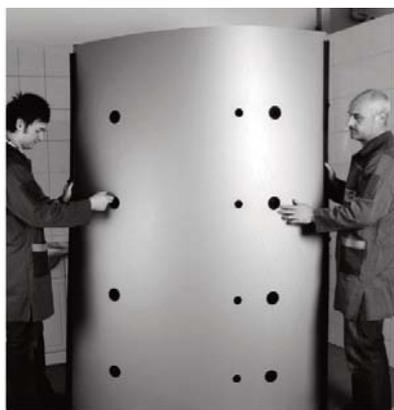
Fig. 30 Inserire il materiale isolante
