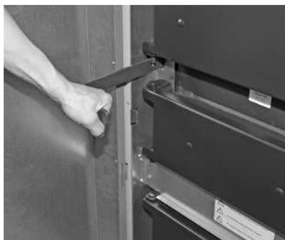
Fig. 28 Azionare la pulizia scambiatore a leva per circa 5 - 10 volte.
