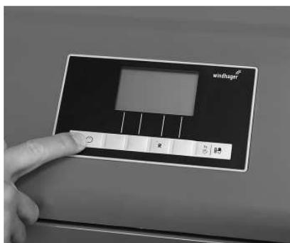
Fig. 74 Spegnere la caldaia
