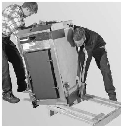
Fig. 13 Rimuovere la caldaia dal pallet
