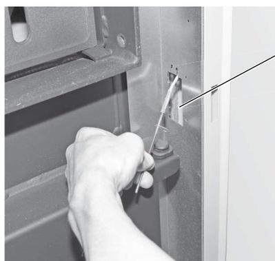
Fig. 47 Passare la sonda Thermocontrol
