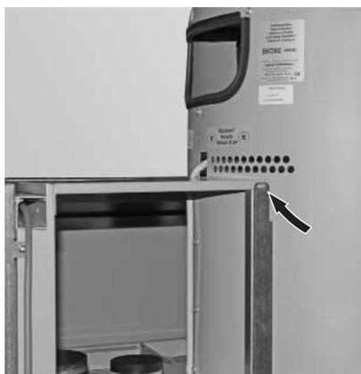
Fig. 122 Avvitare posteriormente il coperchio lato stiva con 1 vite per lamiera all'angolare di montaggio
