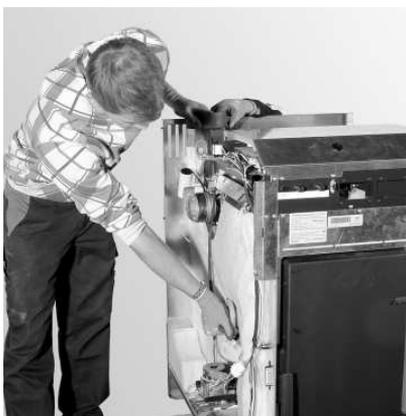
Fig. 12 Posizione della maniglia sul tubo della coclea e sul manicotto per il tubo di evacuazione fumi
