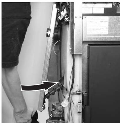
Fig. 84 Infilare la coclea di alimentazione in basso accanto al tubo della coclea
