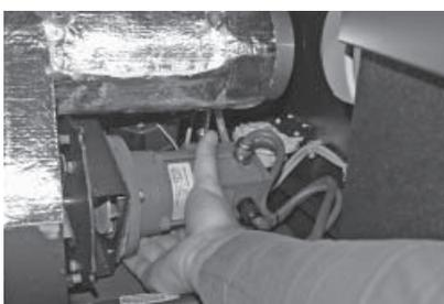
Fig. 154 Togliere i galletti, sfilare il corpo ventilatore
