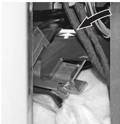
Fig.12 Befestigung oben bis zum Anschlag (Markierung) festschrauben
