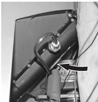
Fig. 14 Fühler für Sicherheitsthermostat-Schneckenrohr ganz einschieben
