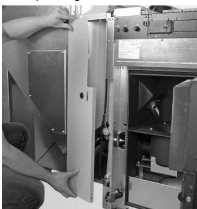
Fig. 33 Encajar el revestimiento en la parte frontal
