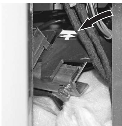
Fig. 11 Avvitare saldamente le viti di fissaggio in alto fino alla battuta (marcatura)
