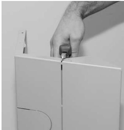
Fig. 25 Cortar el alma en la parte superior e inferior
