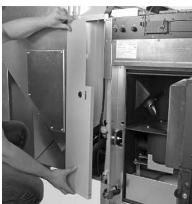
Fig. 33 Verkleidung vorne einfädeln
