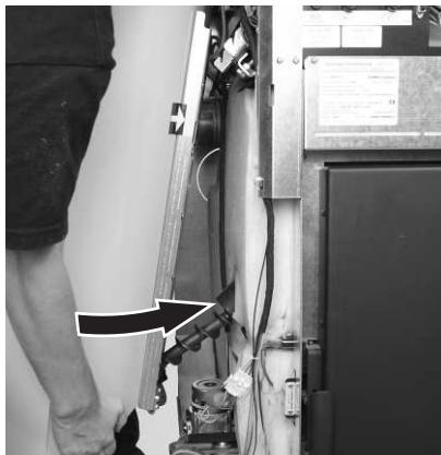
Fig. 9 Faire passer la vis de transport dans le bas, au niveau du tube de vis sans fin
