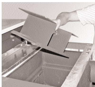
Fig. 50 - Estrarre deviazioni gas combusti.
