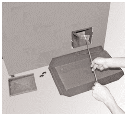
Fig. 55 - Pulire il canale di pulizia.
