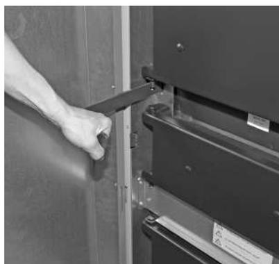
Fig. 62 Azionare la pulizia scambiatore a leva per circa 5 - 10 volte – LogWIN Klassik pellet ready
