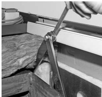
Fig. 51 Avvitare le due leve, non serrare, la tiranteria deve essere mobile
