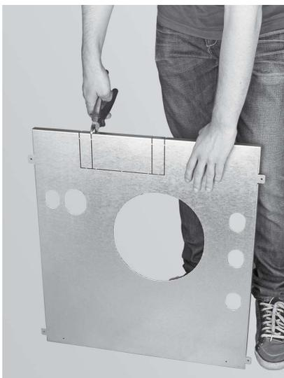
Fig. 45 Se non si utilizza alcun adattatore per raccordo gas combusti, staccare la prepunzonatura
