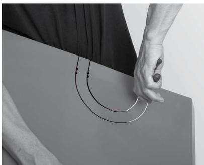
Fig. 65 Se **non** si utilizza alcun adattatore per raccordo gas combusti, staccare la prepunzonatura
