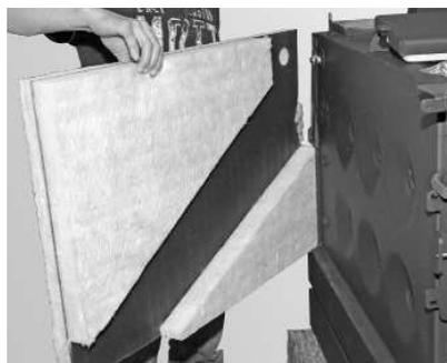
Fig. 26 Montare gli isolament (LogWIN Klassik pellet ready)
