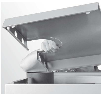
Fig. 70 Togliere la copertura posteriore della caldaia
