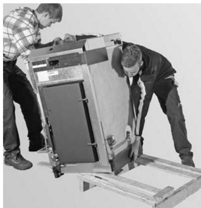
Fig. 12 Rimuovere la caldaia dal pallet
