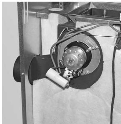
Fig. 30 Riavvitare il ventilatore gas combusti ruotato di 90°
