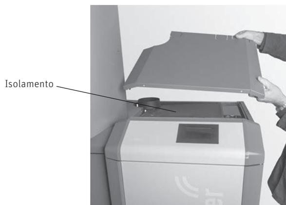
Fig. 101 Togliere il coperchio del rivestimento, rimuovere l'isolamento
