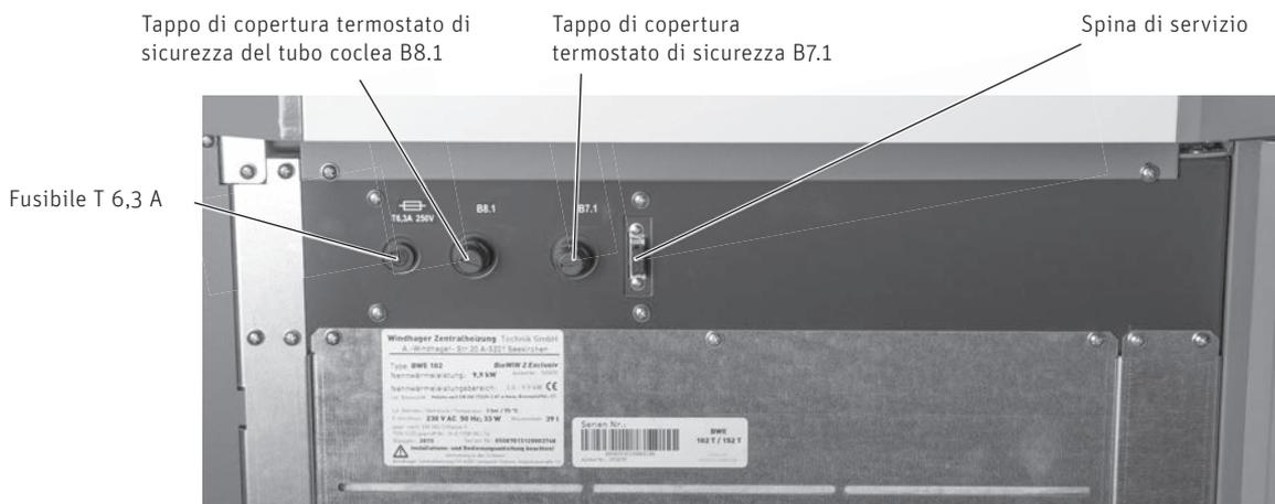
Fig. 84 Quadro di comando BioWIN 2 Touch 102-332
