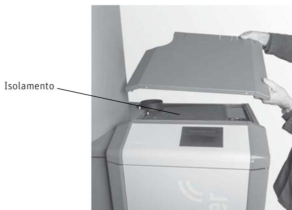
Fig. 105 Togliere il coperchio del rivestimento, rimuovere l'isolamento
