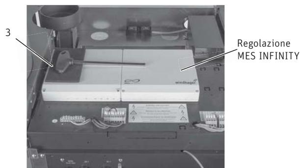
Fig. 81 Incollare il supporto in gomma crepla, vista **con** regolazione MES INFINITY
