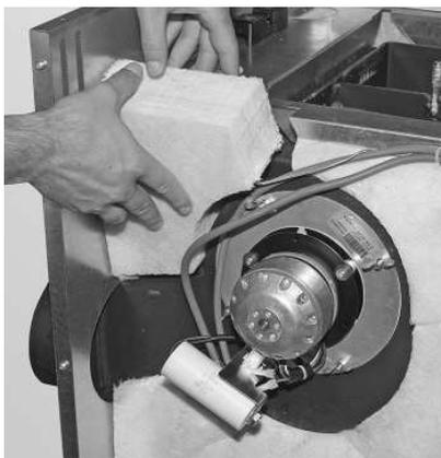
Fig. 33 Applicare l'isolamento (incluso, posto di lato sotto il ventilatore gas combusti)
