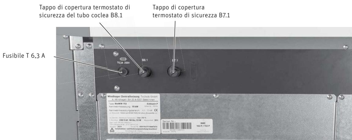
Fig. 86 Quadro di comando BioWIN 2 Touch 102-332
