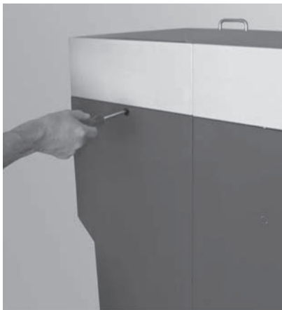
Fig. 59 Agganciare in basso la fiancata posteriore sinistra e fissarla in alto con vite
