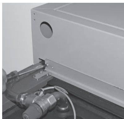
Fig. 51 Fissare davanti il rivestimento stiva con 2 viti
