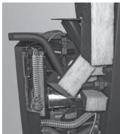
Fig. 20 Montare a tenuta stagna il collegamento filettato e montare il tubo di mandata
