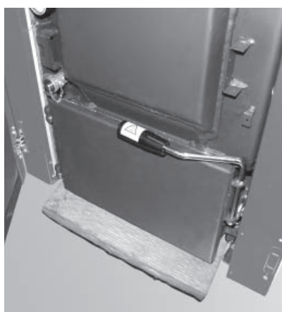
Fig. 62 Inserire l'isolamento del fondo
