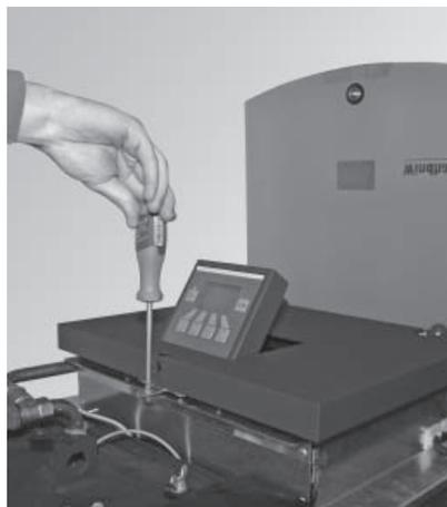
Fig. 24 Sul davanti fissare il coperchio con una vite
