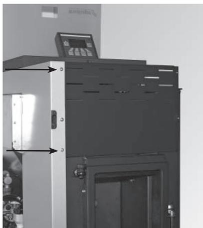
Fig. 27 Avvitare due volte la lamiera di copertura davanti
