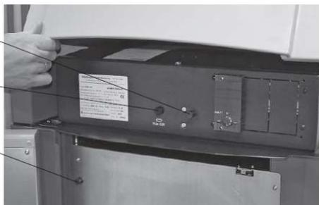
Fig. 148 Sollevare il coperchio del pannello di controllo della caldaia BioWIN e aprire il portello della camera di combustione
