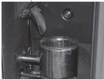
Fig. 125 Pulire il tubo di caduta pellet
